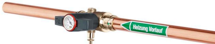
**3** Easytop-Kugelhahn mit SC-Contur, Entleerung, Easytop-Thermometerset und roter Medienkennzeichnung
