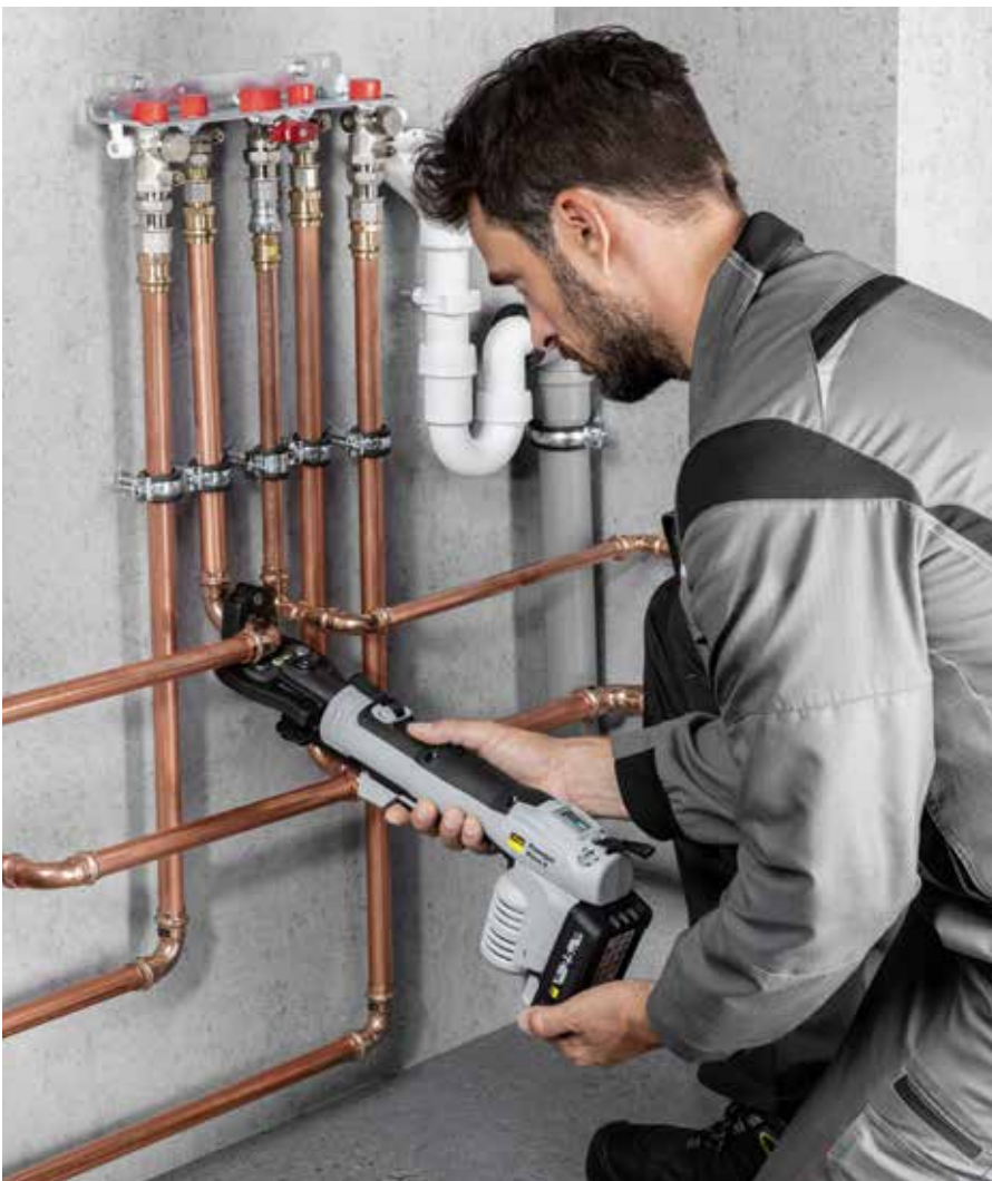
Die um 270° drehbare Pressbackenaufnahme erleichtert die Arbeit an schwer zugänglichen Stellen.
