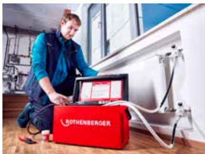
Postopek zamrzovanja se prične avtomatsko po namestitvi zamrzovalnih klešč
